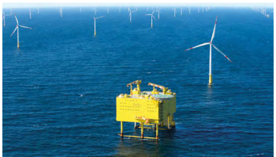
An den Konverterplattformen wird der Windstrom umgewandelt
